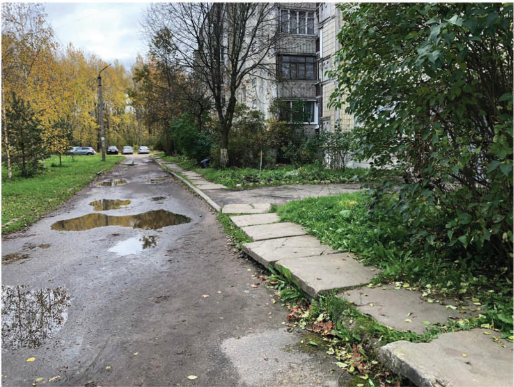
Фотофиксация проезда и пешеходного тротуара (покрытие асфальт и бетонные плиты, - демонтаж и замена покрытия)
