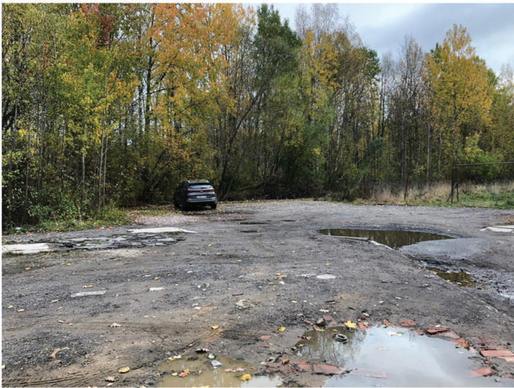
Фотофиксация парковочного места (покрытие частично щебень, частично старый асфальт - демонтаж и замена покрытия)
