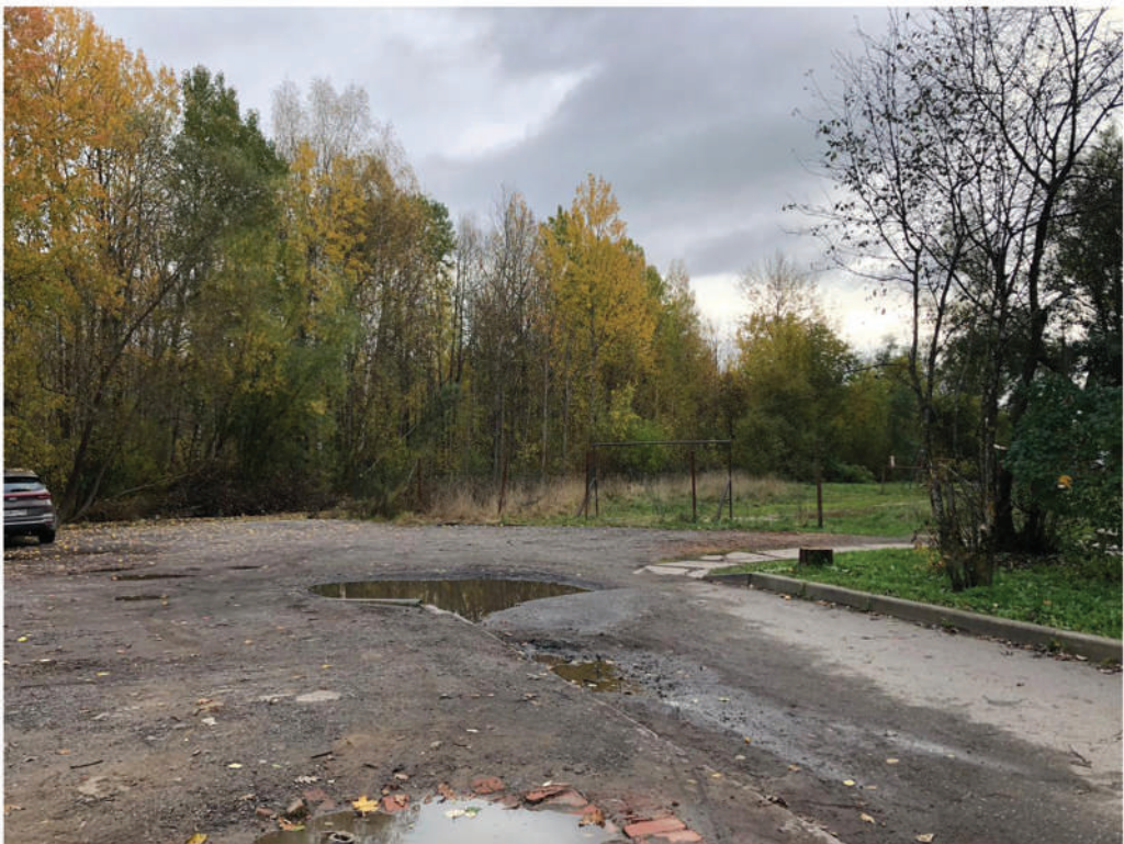
Фотофиксация парковочного места (покрытие частично щебень, частично старый асфальт - демонтаж и замена покрытия)
